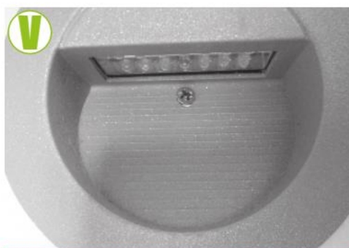
Geïntegreerde wandverlichting
